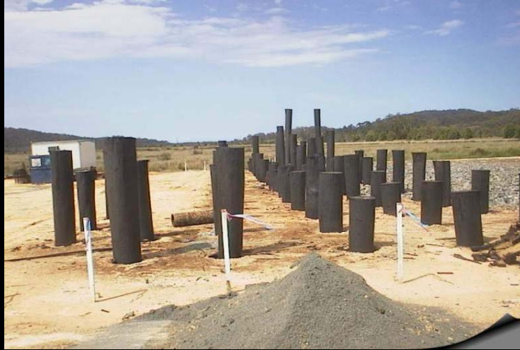
شمع های چوبی کوبیده شده Driven timber piles
